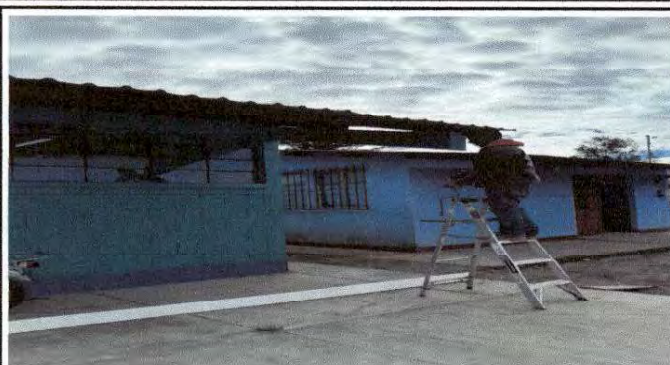
Foto 2: Canales y bajadas de agua.
