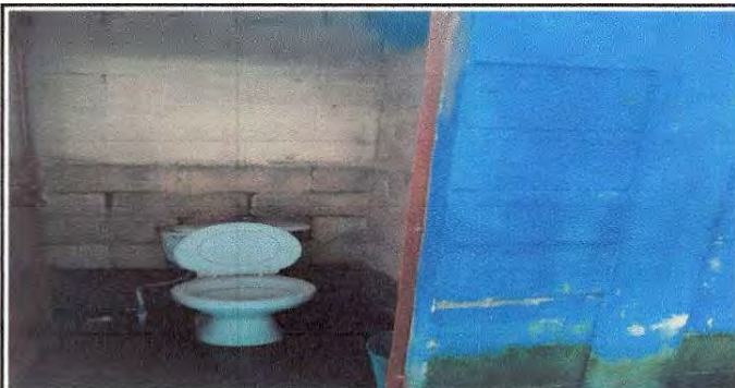
Foto 5: Reparación de puerta de servicio sanitario.
