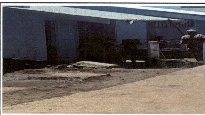
Foto 4: Reparación de piso de torta de concreto.
