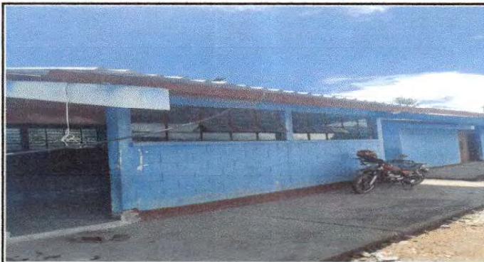
Foto 4: Sustitución de puerta.
